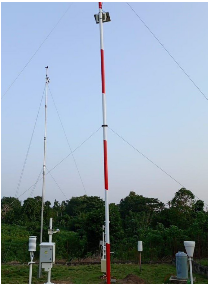
Nouvelle station synoptique automatique
