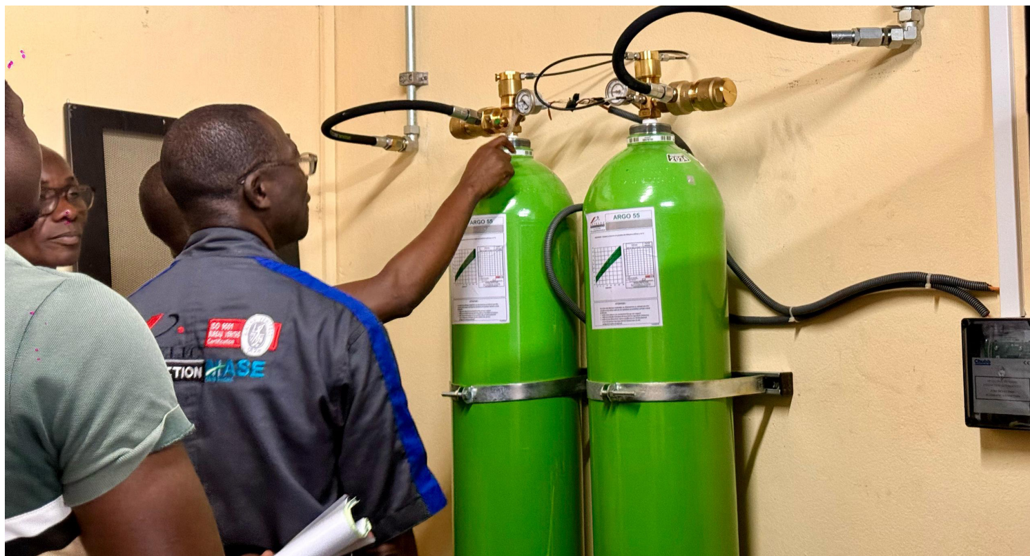
Installation d'un système d'extinction automatique à gaz
