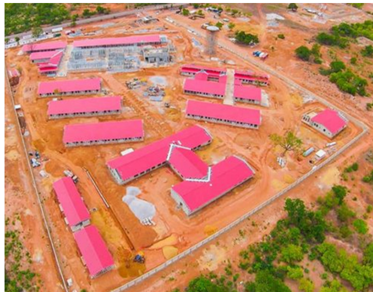
Vue aérienne de l'Hôpital général de la ville de Kouto en construction
